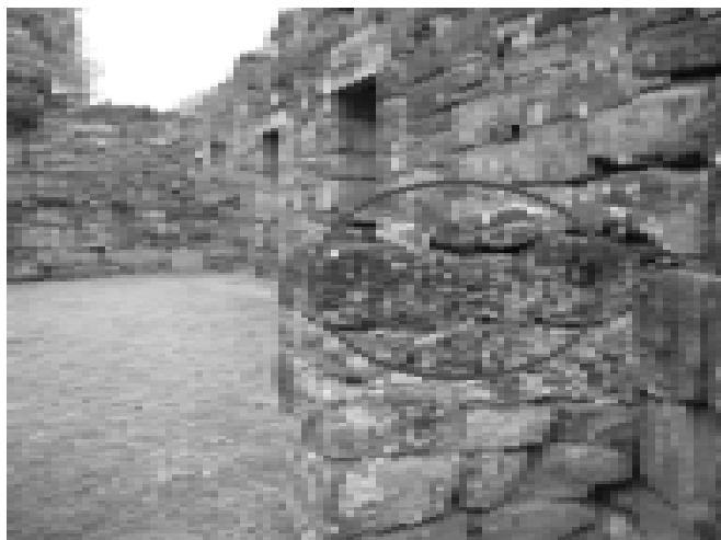
Fig. 9. Daño producido por hongos, briofitas, etc. en las Ruinas de San Ignacio Mini, Misiones.
