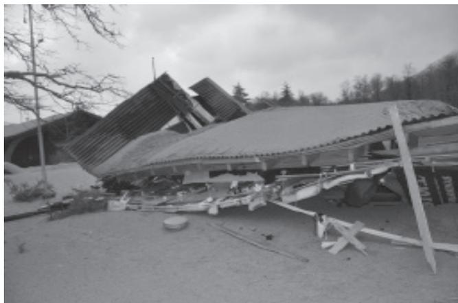
**Figura 4: Colapso del techo del quiosco de la Aduana argentina por sobrecarga de ceniza y nieve, en el paso fronterizo Cardenal Samoré. Junio de 2011.**
