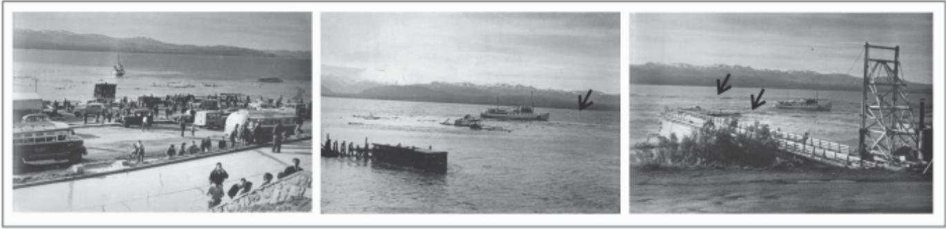
**Figura 6. Fotografías tomadas en el sector de Puerto San Carlos el día 22 de mayo de 1960, donde se observan los restos del muelle colapsado y los daños ocasionados a las embarcaciones Modesta Victoria y Cruz del Sur. Las flechas indican el avance de algunas ondas en la superficie del lago, posible efecto posterior a la ocurrencia del tsunami.** Fuente Diario Digital Bariloche 2000 ([www.bariloche2000.com](http://www.bariloche2000.com)).- +
