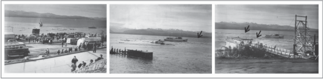
Figura 6. Fotografías tomadas en el sector de Puerto San Carlos el día 22 de mayo de 1960, donde se observan los restos del muelle colapsado y los daños ocasionados a las embarcaciones Modesta Victoria y Cruz del Sur. Las flechas indican el avance de algunas ondas en la superficie del lago, posible efecto posterior a la ocurrencia del tsunami. Fuente Diario Digital Bariloche 2000 ( www.bariloche2000.com ).- +
