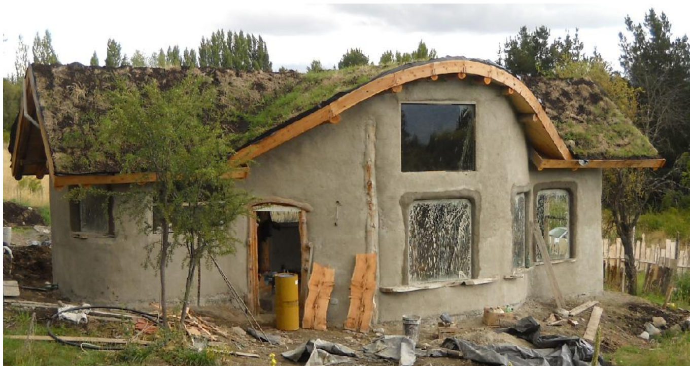
Figura 2. Casa con envoltante de bloques de paja y arcilla, revocada con arcilla y arena, en etapa de terminación.
